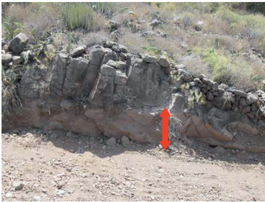
Foto 1. Foto donde se representa la formación de un acceso y plataforma mediante terraplén en el lecho del cauce que altera su perfil longitudinal.
