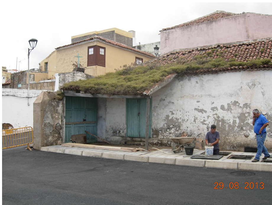
Foto desde la vía de acceso al sector R-20 de la portada con el muro de cerramiento que se mantiene en el ámbito de la acera.
