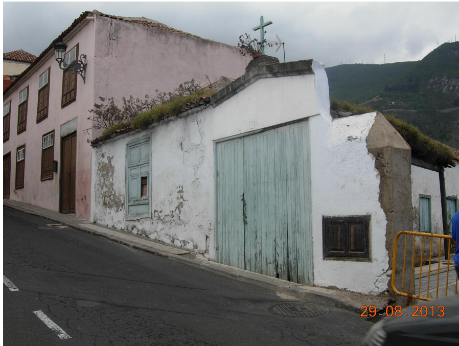
Foto desde la calle cantillo de abajo de la portada con el muro de cerramiento que se mantiene en el ámbito de la acera.
